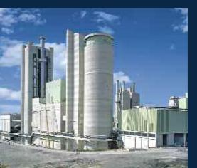
Silo d'homogénéisation de farine粗, effets de mélange élevés avec faible consommation d'énergie
